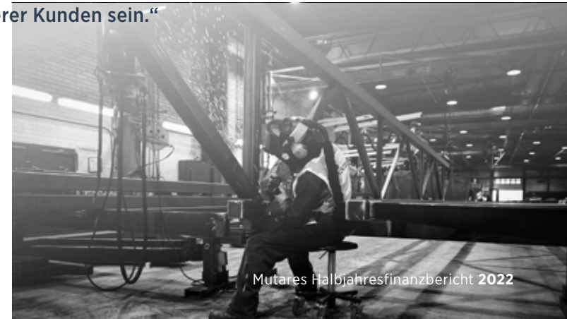
Fertigungsteile für eine Autobahnbrücke
